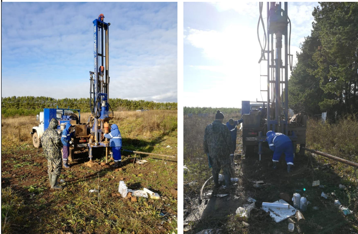
Рис. 2 Проведение буровых работ на скважинах №№ 1 и 2
