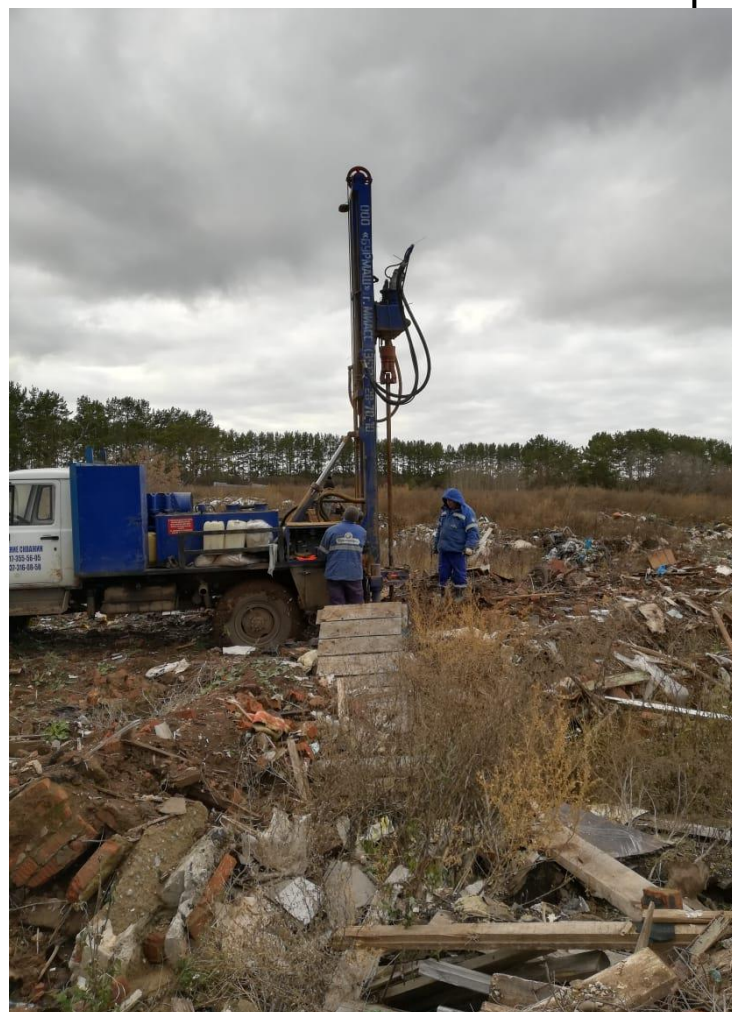
Рис. 1 Проведение буровых работ на скважинах №№ 3 и 5
